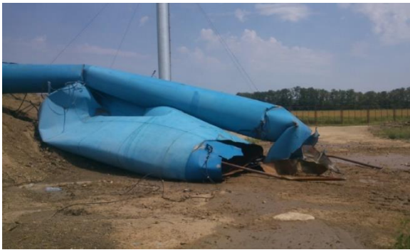
Рис. 2. Обрушение башни Рожновского вследствие потери местной устойчивости стенки
