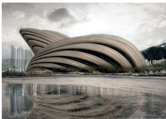
Рис. 8. Здание-ракушка в Южной Корее от студии OODA. Fig. 8. Shell building in South Korea by OODA Studio.
