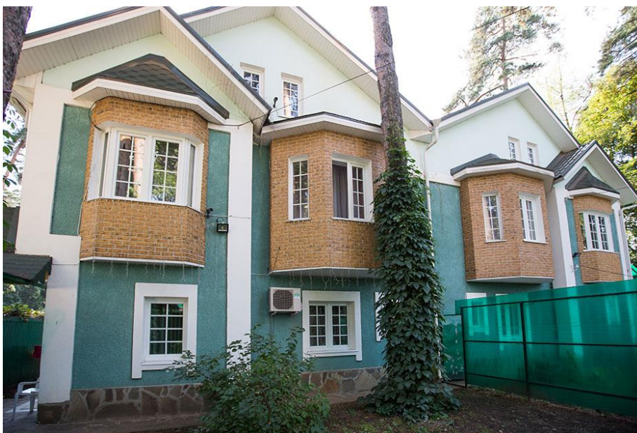
Рис.6. Фасад здания дома престарелых в Малаховке. Fig. 6. Facade of the building of a nursing home in Malakhovka.
