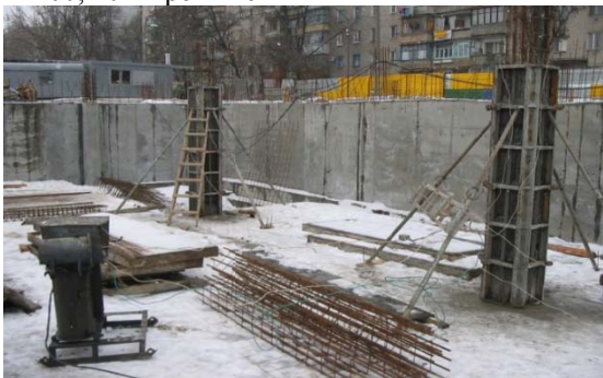
Рис. 3.Общий вид участка ухода за бетоном колонн с электропрогревом и химдобавками
