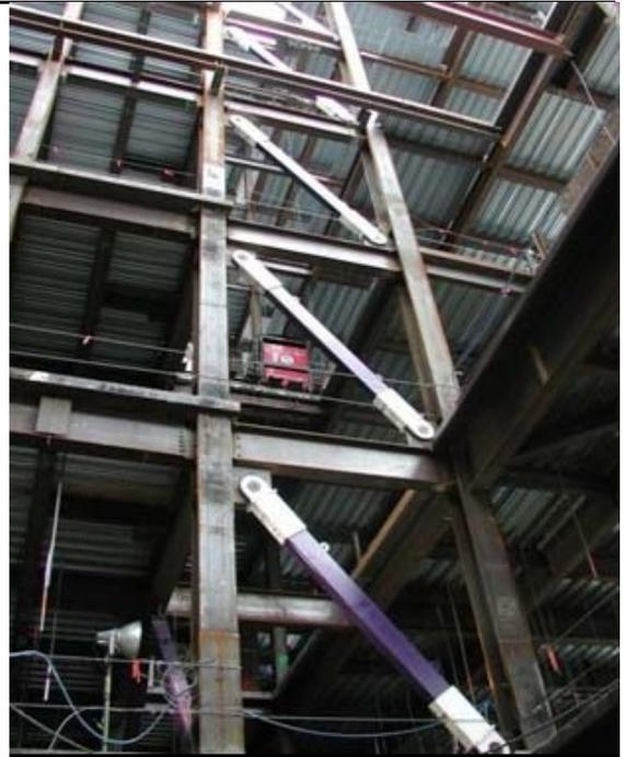
Рис.7. Усиливающие стержни в качестве раскосов.
