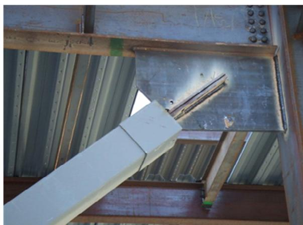
Рис.5. Сварное соединение.
