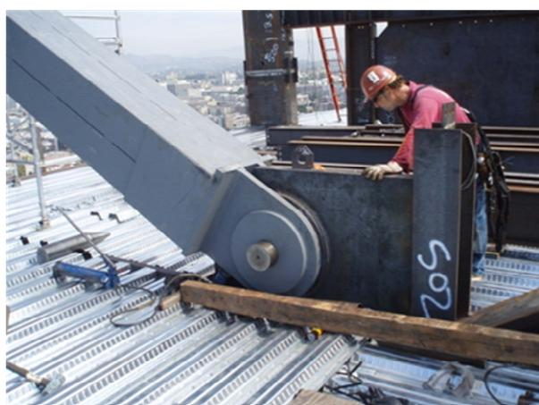
Рис.4. Шарнирное, штифтовое соединение.
