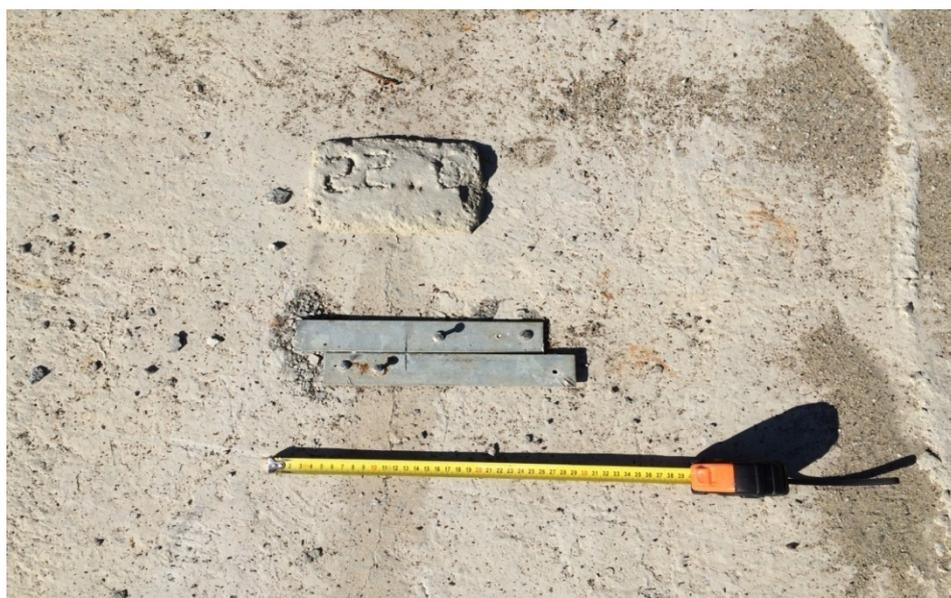
Рисунок 1– Трещина в фундаментной плите хранилища. Маяк над трещиной
