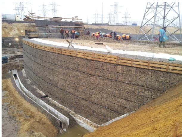
Рисунок 2 Устройство облицовки из коробов габиона.
