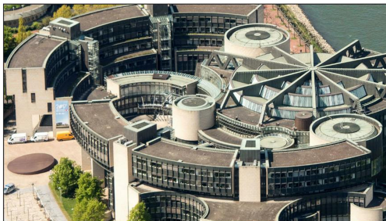
Рис. 9. Ландтаг земли Северный Рейн-Вестфалия, архитекторы: Фриц Эллер, Эрик Мозер и Роберт Уолтер Fig. 9. Landtag of North Rhine-Westphalia, architects: Fritz Eller, Eric Moser and Robert Walter
