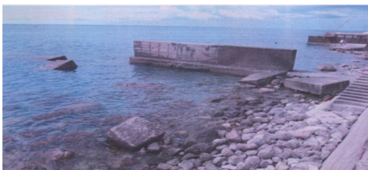
Рис. 5. Разрушенные буны в районе г. Ялта. Южный берег Крыма Fig. 5. Destroyed groynes in the area of Yalta. South coast of Crimea
