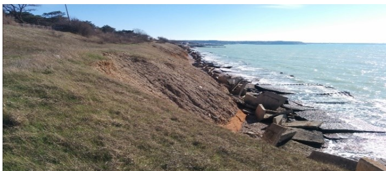
Рис. 4. Разрушенная набережная и эрозия клифа в с. Песчаное. Западный берег Крыма Fig. 4. Destroyed embankment and cliff erosion in Peschanoye village. Western coast of Crimea
