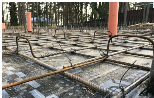
Рис. 3. Фото армирования фундаментной железобетонной плиты
